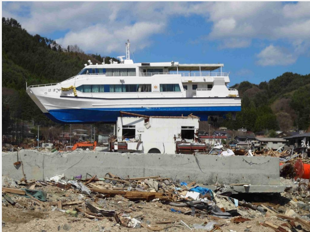
津波によって打ち上げられ、ビルに乗り上げた観光船（岩手県大槌町）
